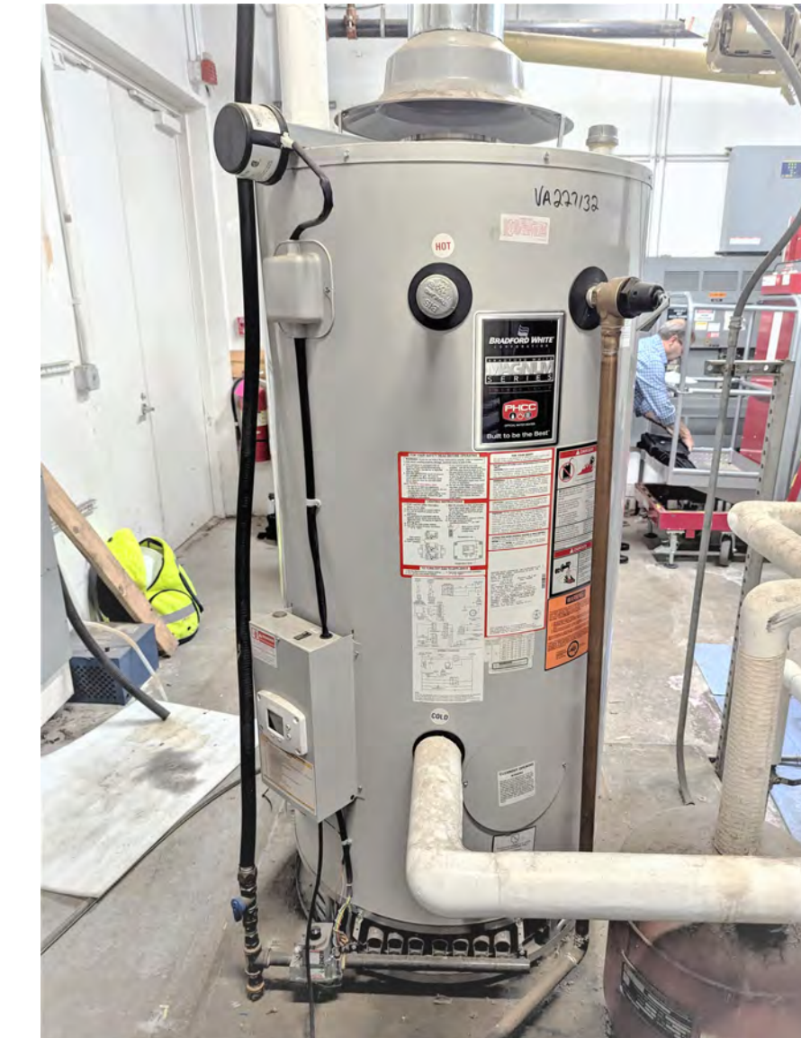
B1 EXISTING DHW PROPANE SYSTEM SCALE: N.T.S.
