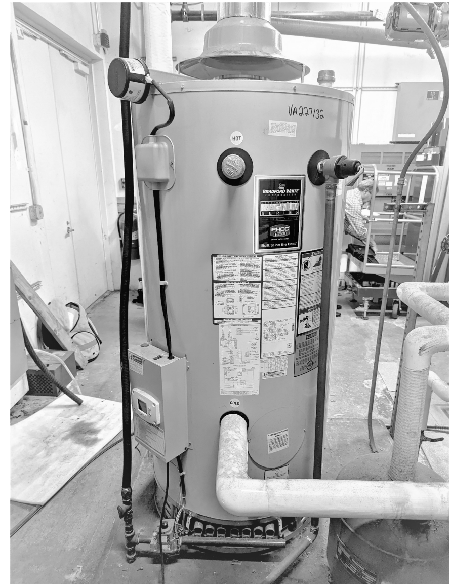
B1 EXISTING DHW PROPANE SYSTEM SCALE: N.T.S.
